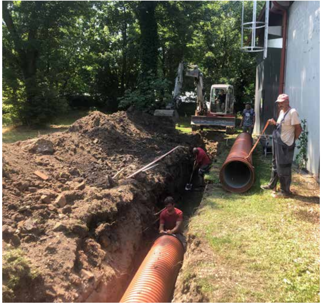
Die Gemeindemitarbeiter bei den Bauarbeiten
